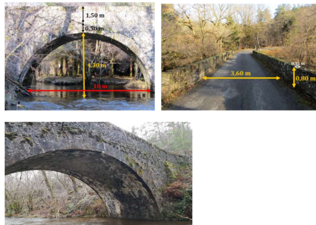
Figure 1 – Pont de Fioux
