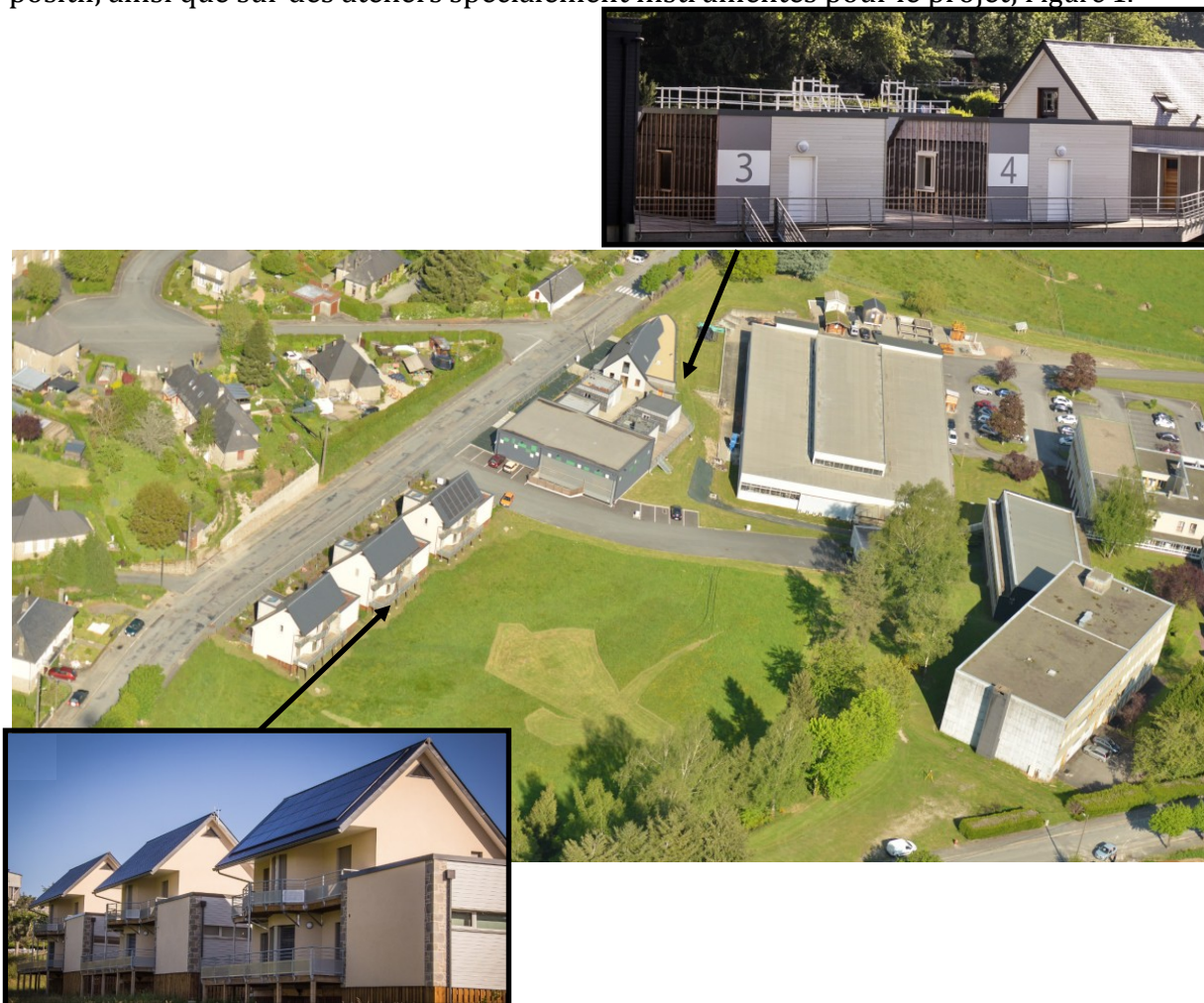
Figure 1 : Centre Universitaire Génie Civil d'Egletons, avec détails des 3 maisons instrumentées et des ateliers.
