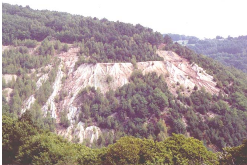
Figure 1 Vue actuelle du site d'Enguialès (Aveyron), où jusqu'en 1979, date de la fermeture, les stériles ont été déversés à même la pente (Cliché A. Courtin)
